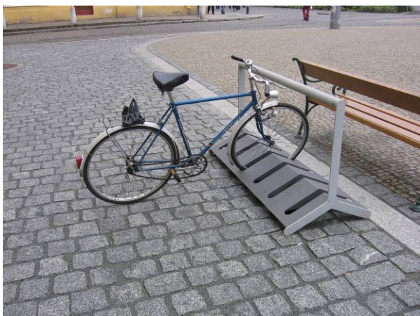
Obr. 38: Nevhodný stojan z důvodu nemožnosti zamčení rámu kola ke stojanu a chybějící opory kola – poškozuje přední kolo. Zdroj: Sperat
