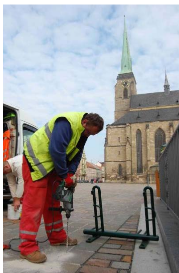
Obr. 56: Instalace stojanů na krátkodobé parkování. Zdroj: Žáková
