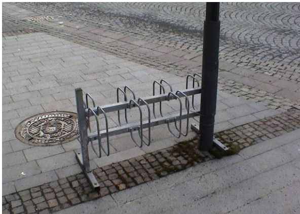
Obr. 33: Nevhodný stojan z důvodu kotvení, možného poškození stojanu a uchycení jízdního kola. Zdroj: Žáková
