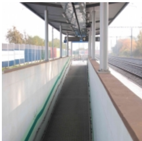
Obr. 76: Kozolupy – bezbariérový přístup na nástupiště.
