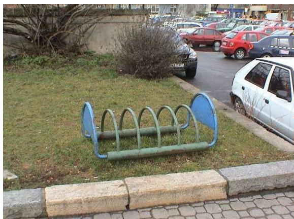
Obr. 34: Nevhodný stojan z důvodu kotvení, možného poškození stojanu a uchycení jízdního kola. Zdroj: Žáková
