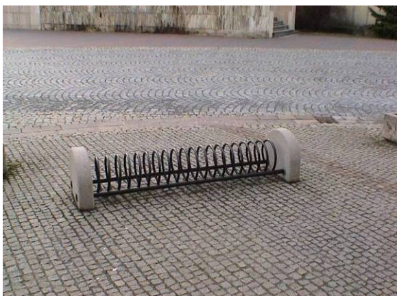
Obr. 33: Nevhodný stojan z důvodu kotvení, možného poškození stojanu a uchycení jízdního kola. Zdroj: Žáková
