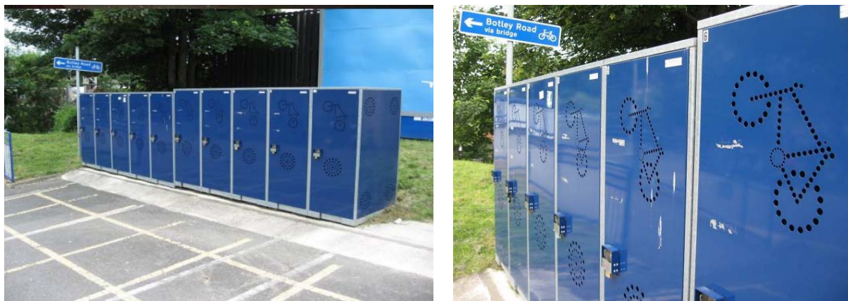
Obr. 10, 11: Boxy pro jízdní kola před železniční stanicí v anglickém Oxfordu. Zdroj: Galatík
