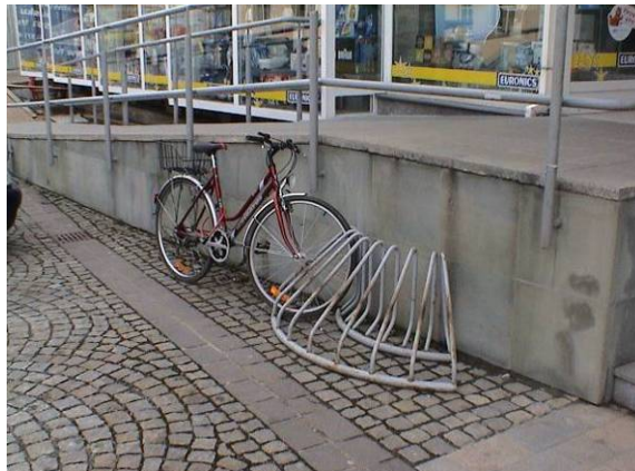
Obr. 34: Nevhodný stojan z důvodu kotvení, možného poškození stojanu a uchycení jízdního kola. Zdroj: Žáková
