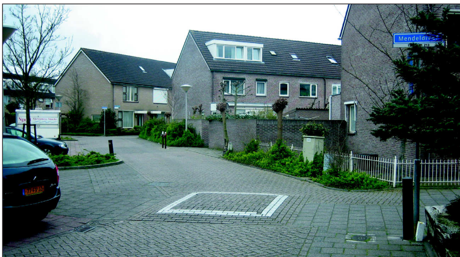
Obr.18: Příklad zpomalovacího polštáře v obytné zóně (Lisse, Nizozemsko).
