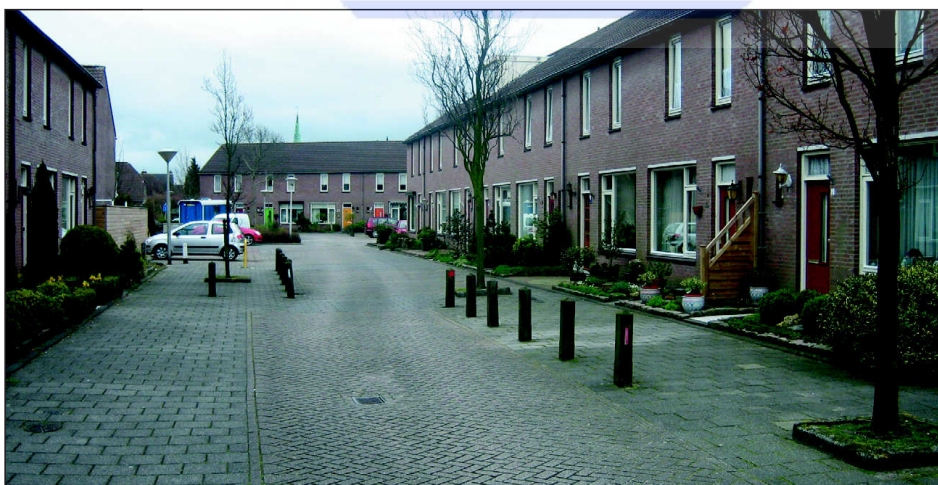
Obr.21: Příklad sloupků v obytné zóně oddělujících dopravní a pobytový prostor (Lisse, Nizozemsko).
