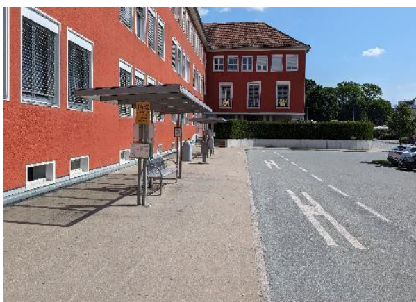
Nedostatečná ochrana proti povětrnostním vlivům v prostoru pro čekání cestujících (autobusové nádraží ve Stegersbachu/Rakousko). Foto: © Andreas Friedwagner
