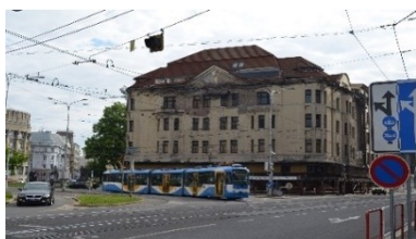
Obr.15: Budova ve špatném stavu, zdroj: OU, 2020
