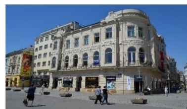
Obr.17: Dobrý stav budovy, zdroj: OU, 2020
