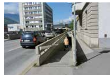
Fehlende Querung auf Strassenniveau.
