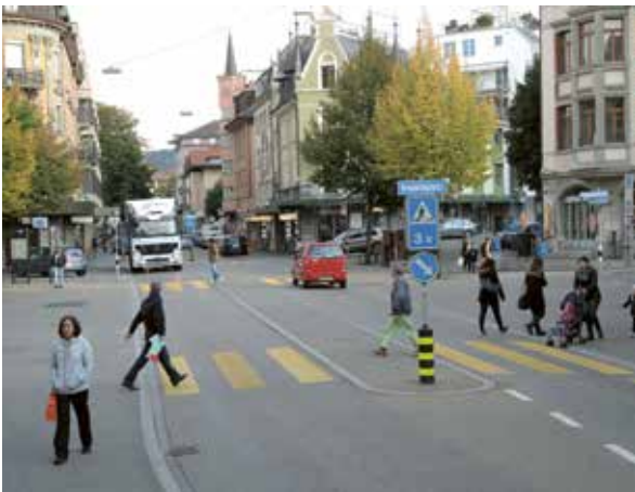
Mittelinseln minimieren die Querungsdistanz und erlauben das Queren in zwei Etappen.
