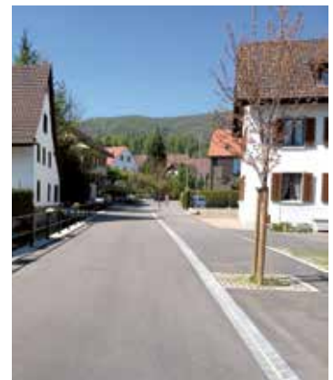
Einseitiges Trottoir entlang Quartierstrasse.
