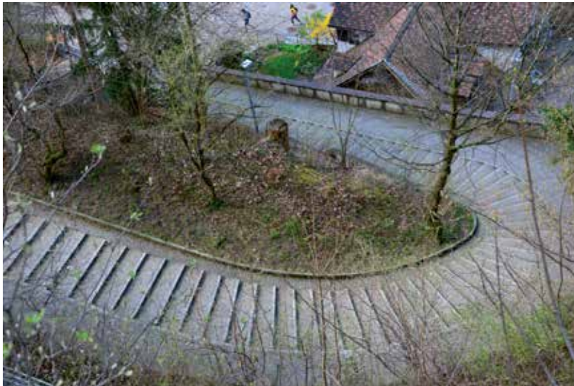
Kombinierte Rampen- und Treppenanlage.
