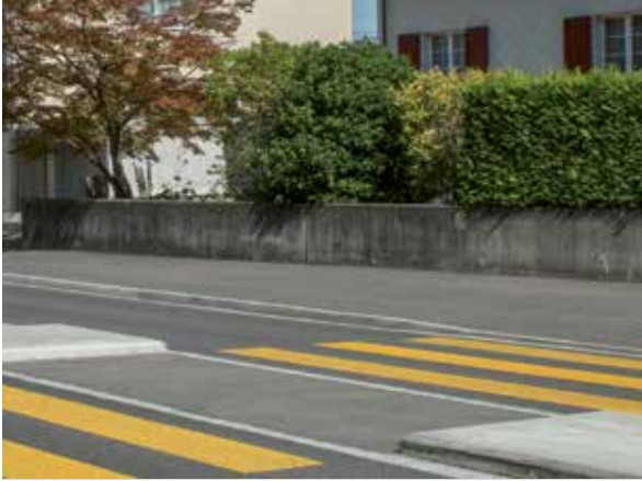
Das Trottoir mit hohem Randabschluss ist im Bereich des Fussgängerstreifens auf 3 cm senkrecht abgesenkt.
